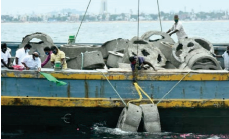
చిత్రం 35. ముందుగా అనుకున్న రేఖాంశాల (కో-ఆర్డినేట్) వద్ద రీఫ్ విభాగాలను విడుదల చేసి ప్రారంభం చెయ్యడం
